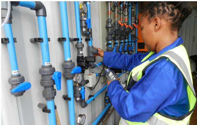
Entnahme einer Wasserprobe im Demonstrator.
